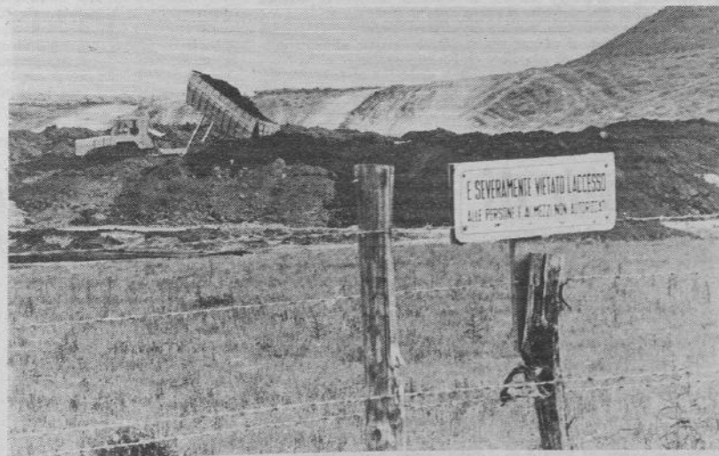
Doppio reticolato per il cantiere nucleare di Pian dei Gangani
