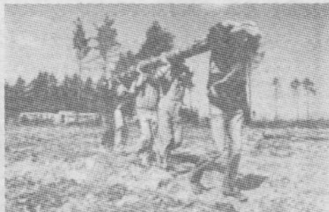
Goxleben: si cominciano a costruire case sul terreno occupato dove dovrebbe sorgere una centrale nucleare.
