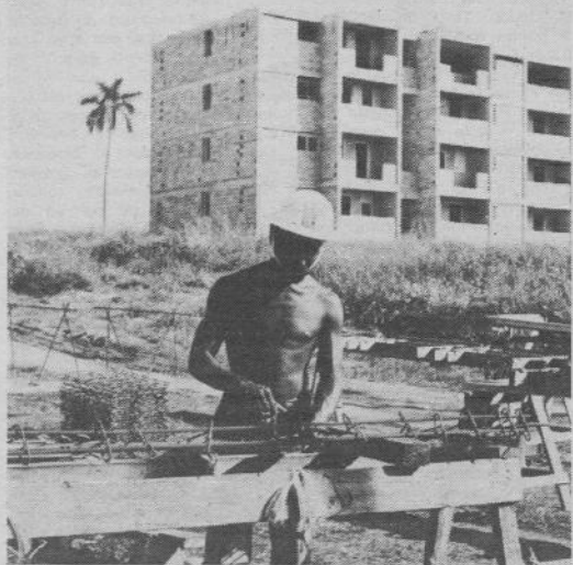
Un cantiere edile a L'Avana.
