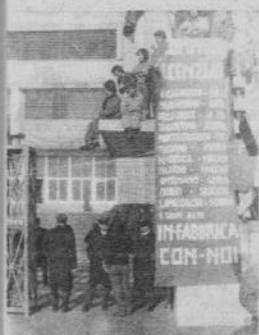
FIAT 1973 - Con l'occupazione della fabbrica, i licenziamenti vengono (quasi tutti) riassunti
