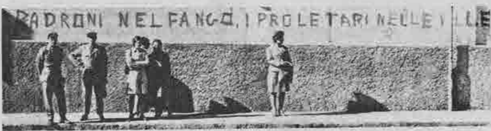
SUI MURI DI GENOVA, DOPO L'ALLUVIONE
