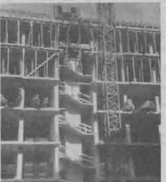
Cantiere di via Piave, impresa Giulio: come si vede, mancano ponteggi, parapetti, ogni misura di sicurezza.
